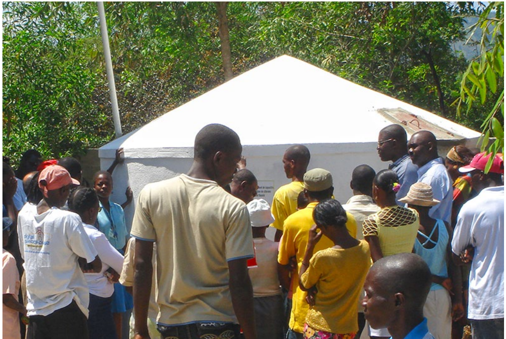
Presentación de la construcción de una cisterna a la comunidad
